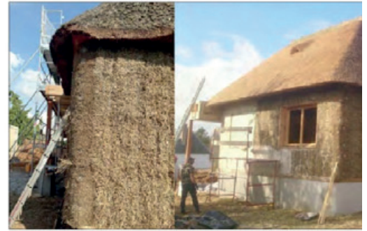
Des bottes de paille ont été utilisées pour isoler la Chaumière, crèche située à Bréauté. Plus d'explications au festival Yes We Caux
